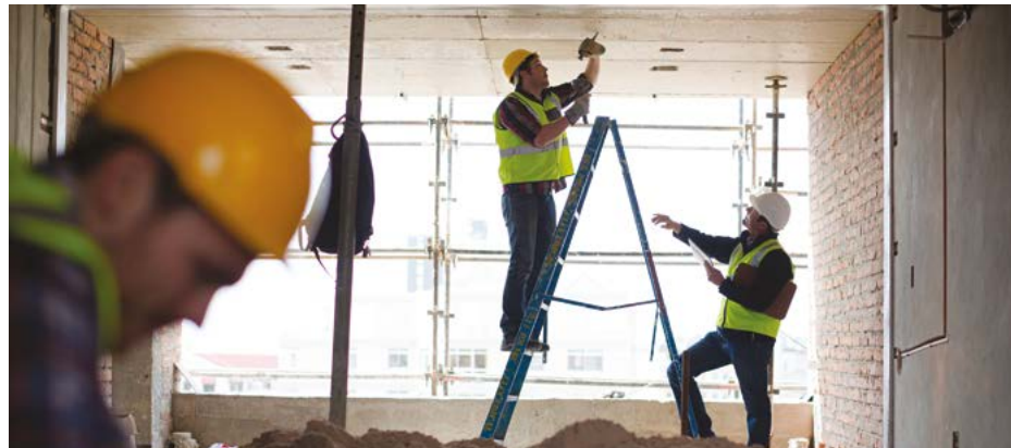
Per accedere ai cantieri edili sarà necessario un badge digitale
