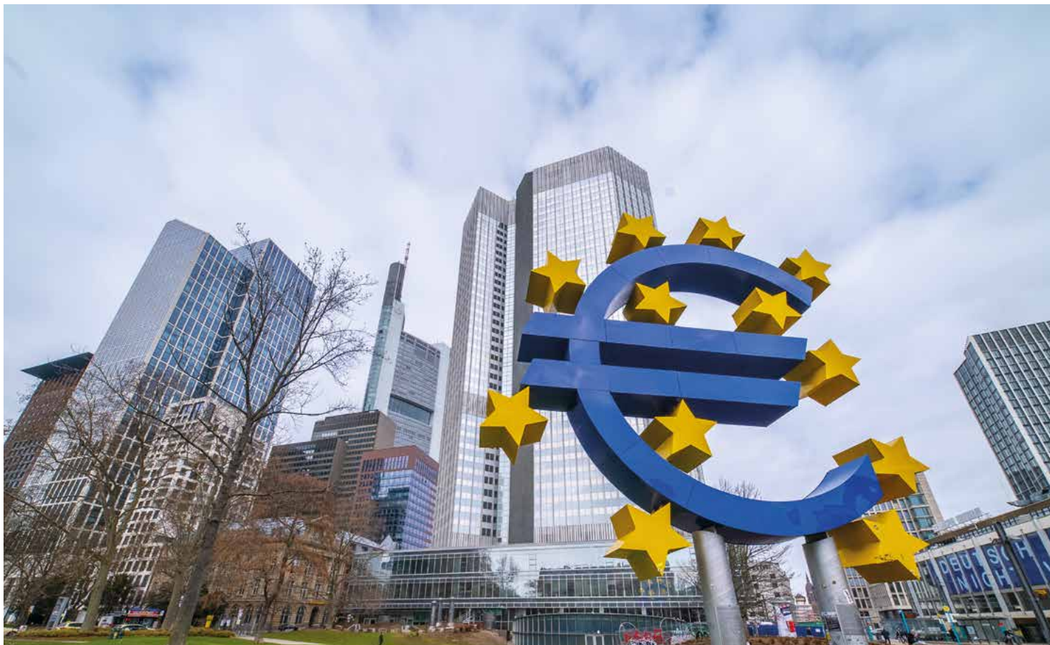
La sede della Banca Centrale Europea a Francoforte sul Meno (Germania)
