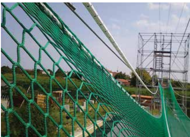
Sopra e a destra, due immagini del Parco di innovazione per le imprese in via di costruzione e che sarà sede di Kirecò
