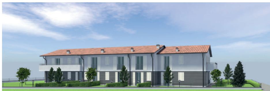
Il progetto in costruzione a Solarolo: 11 villette a schiera e 5 appartamenti autonomi
