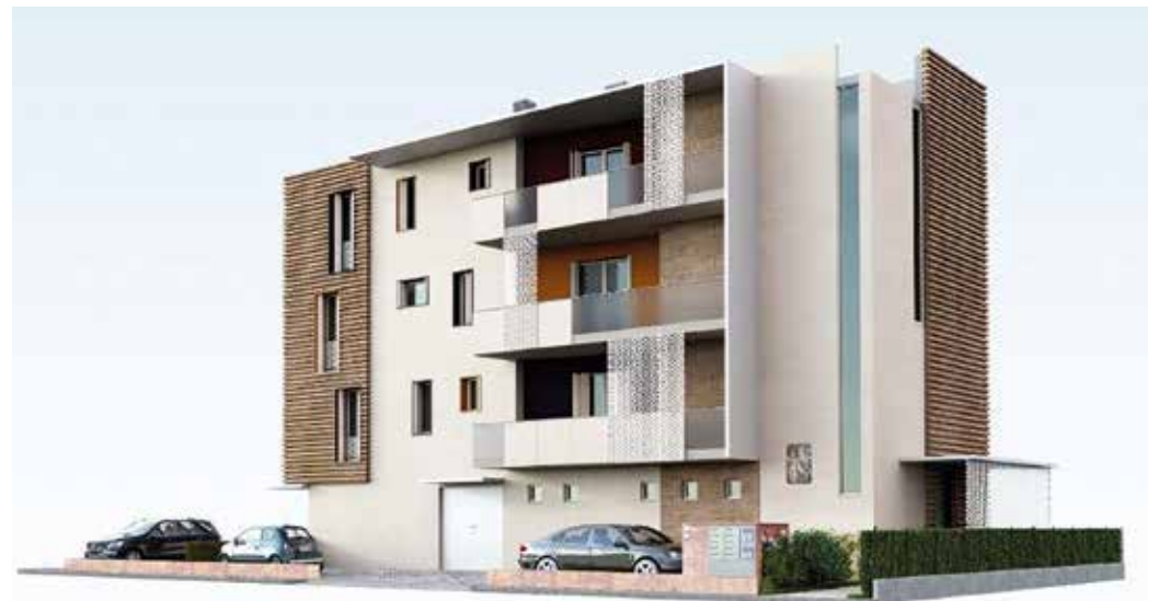
Il progetto di via Forlivese in via di ultimazione
