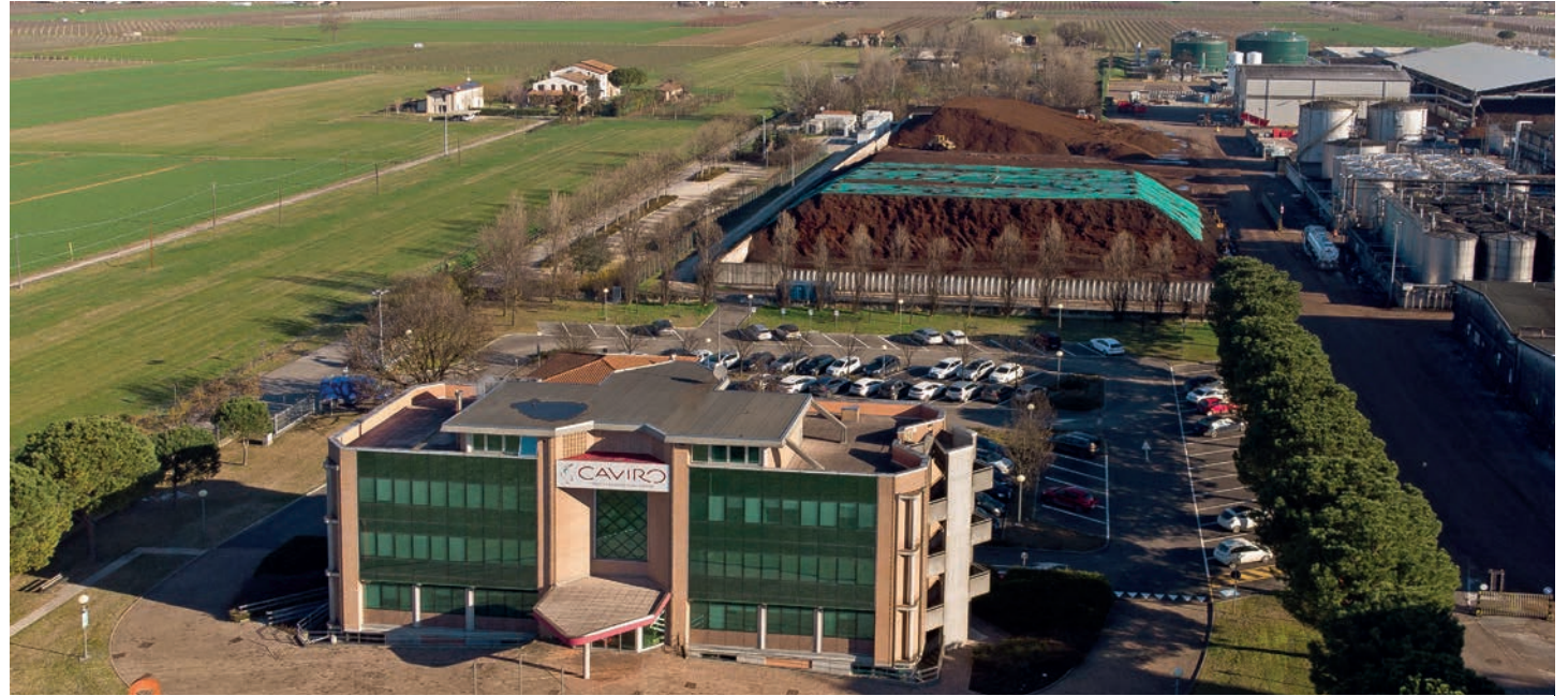
Una panoramica dello stabilimento Caviro di Faenza. Foto di Sergio Montanari
