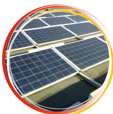
Interventi di risparmio energetico
