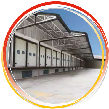
Manutenzioni civili e industriali
