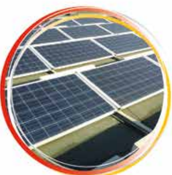
Interventi di risparmio energetico
