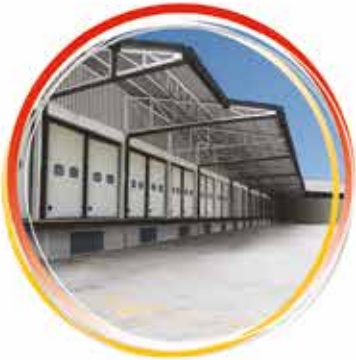
Manutenzioni civili e industriali
