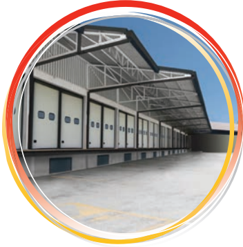
Manutenzioni civili e industriali
