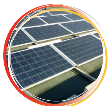
Interventi di risparmio energetico
