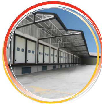
Manutenzioni civili e industriali
