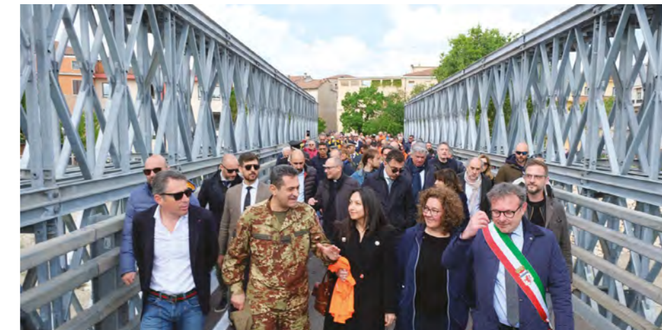
Faenza. L'inaugurazione del ponte Bailey
