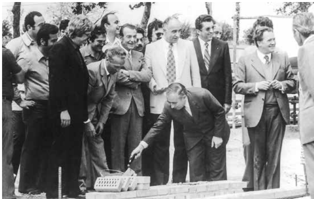
Cesena, 1976: la posa della prima pietra dello stabilimento Orogel
