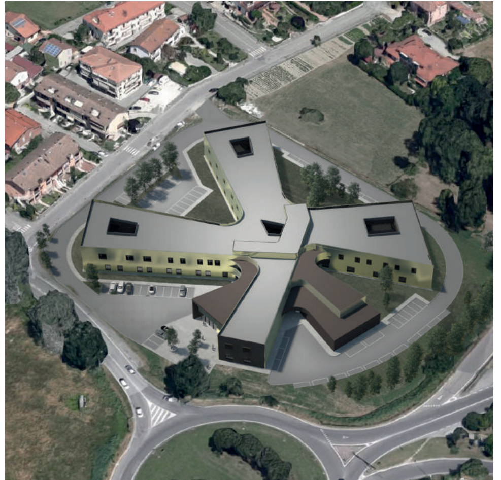
Il complesso multifunzionale destinato alla popolazione anziana di Ravenna "Rosa dei Venti" di cui Cmcf è partner
