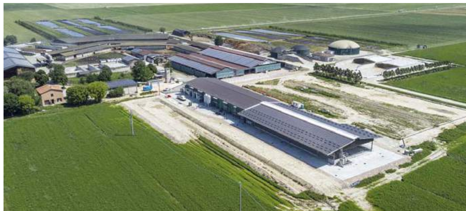
La struttura della cooperativa agricola Libertà e Lavoro a Ravenna
