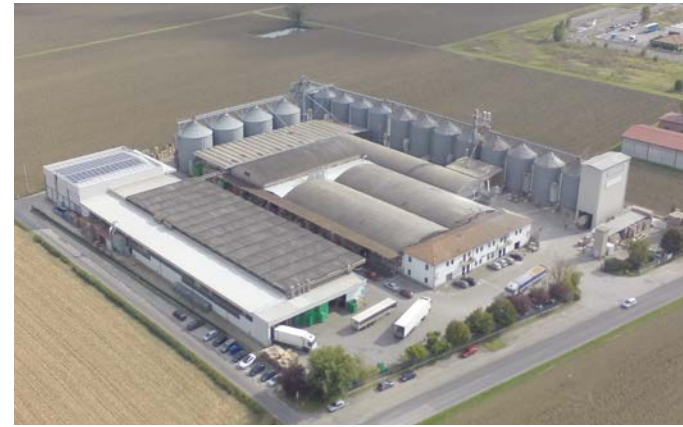
Lo stabilimento di Castel Guelfo
