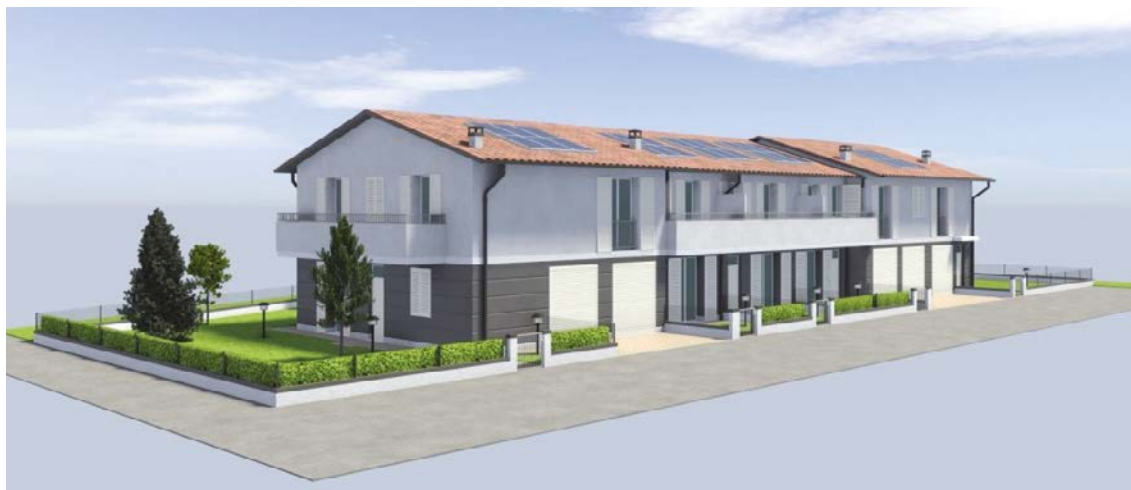
Villetta a schiera in costruzione a Solarolo
