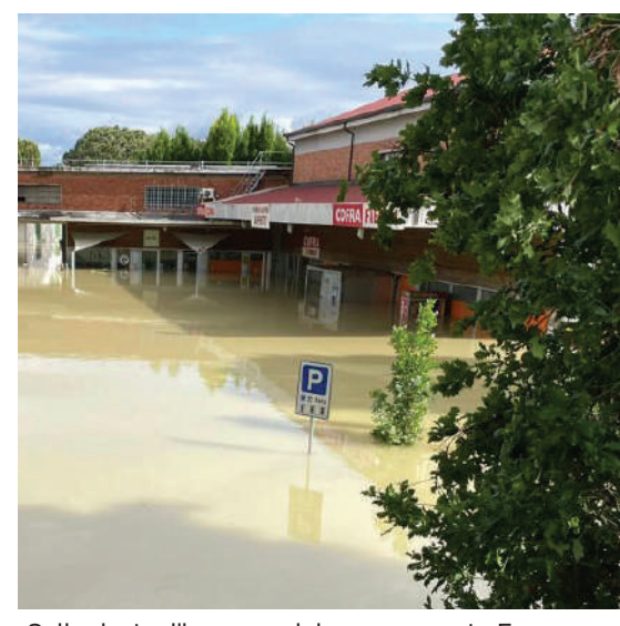
Sulla destra l'ingresso del supermercato Faenza 1 di via Renaccio il giorno dopo l'alluvione
