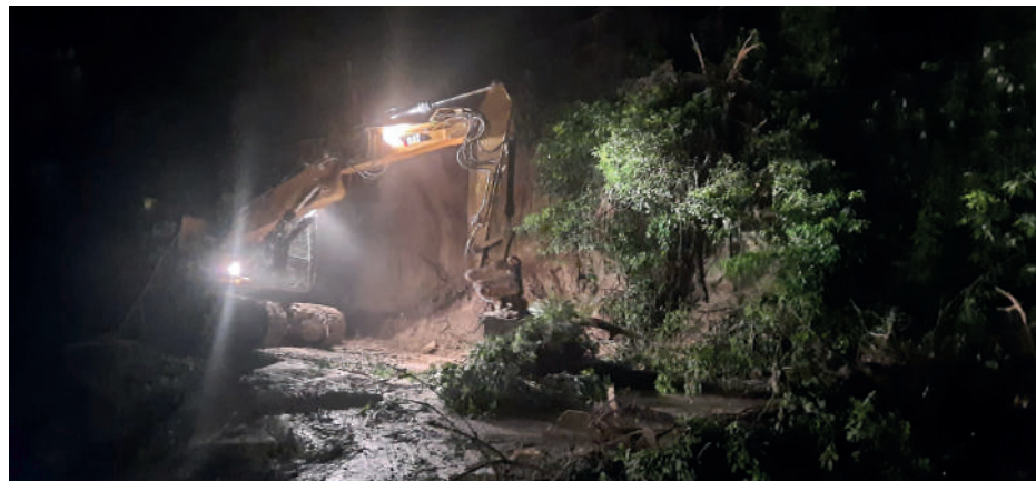
La cooperativa Clas di San Piero in Bagno ha lavorato notte e giorno per ripristinare i collegamenti stradali
