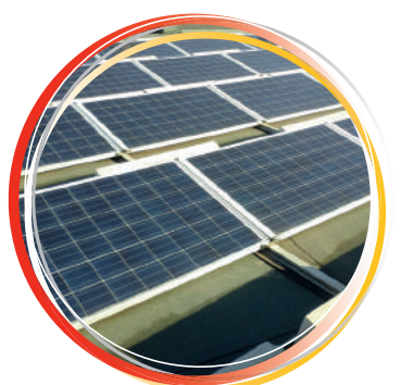
Interventi di risparmio energetico
