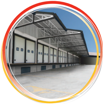
Manutenzioni civili e industriali
