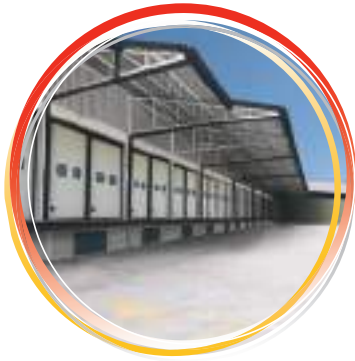
Manutenzioni civili e industriali
