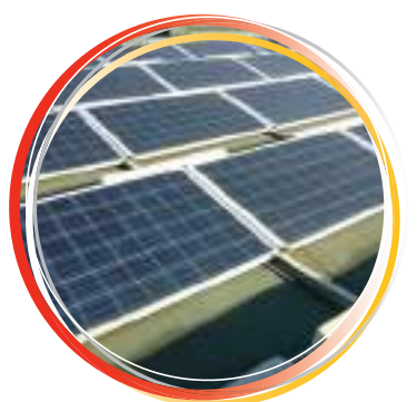
Interventi di risparmio energetico
