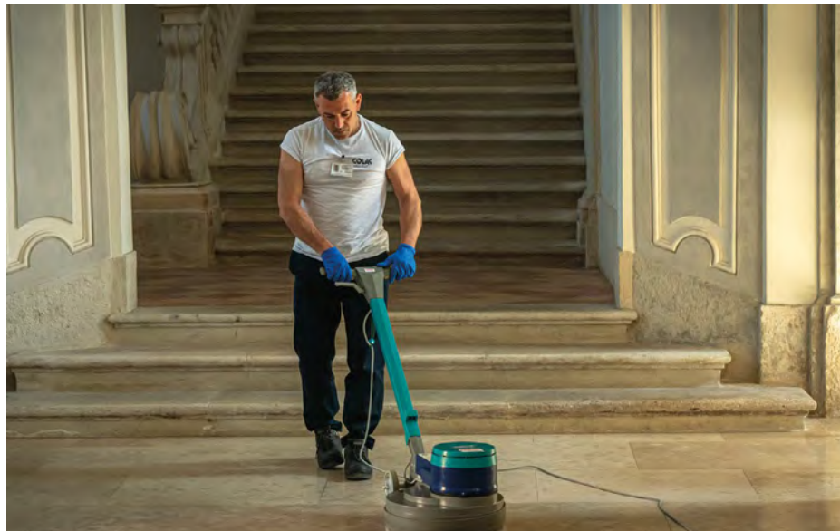
Un operatore Colas al lavoro a Palazzo Rasponi dalle Teste di Ravenna
