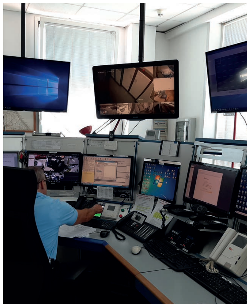
La centrale operativa di Colas Vigilanza
