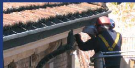
Interventi di lattonerie
