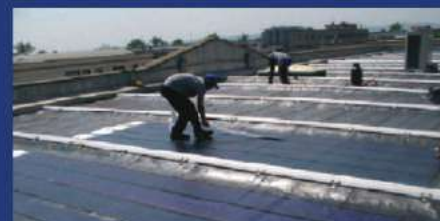
Impermeabilizzazione manto fotovoltaico integrato
