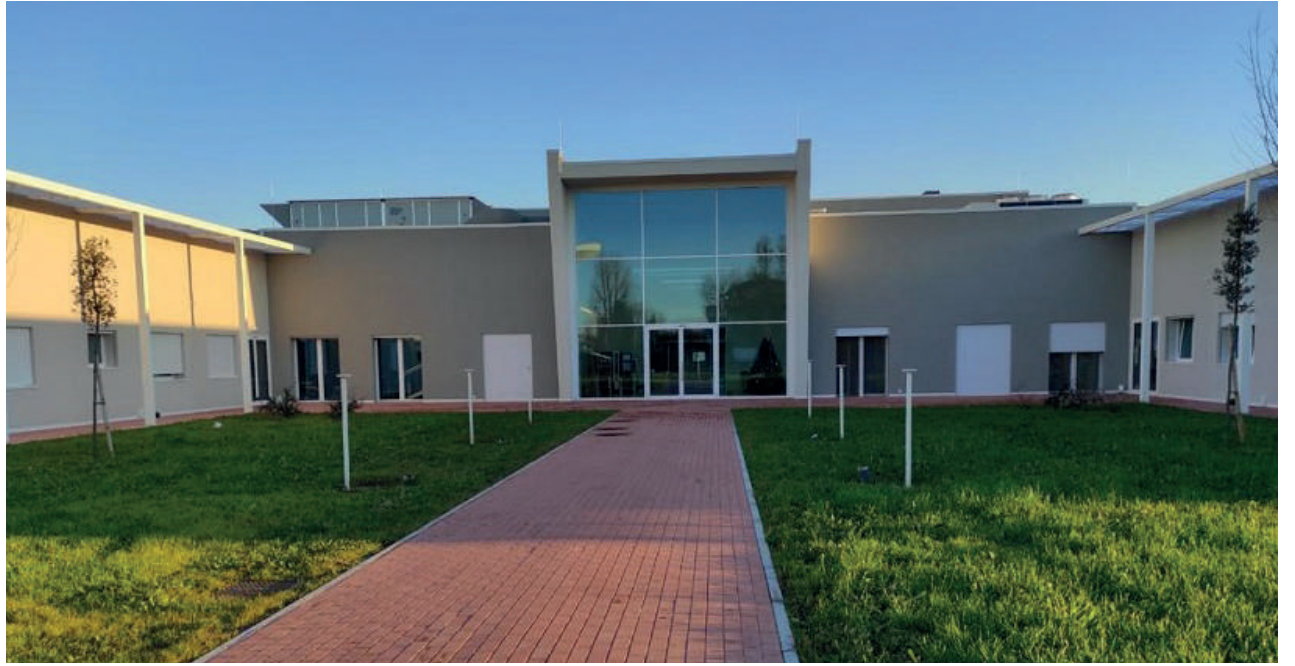
La Cra La Meridiana 2 di Bellaria aperta in tempi rapidi nel marzo del 2020 per ospitare un reparto di quarantena in accordo con Ausl Romagna. Oggi la Cra è operativa in regime normale di accreditamento e può ospitare 64 persone
