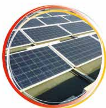
Interventi di risparmio energetico
