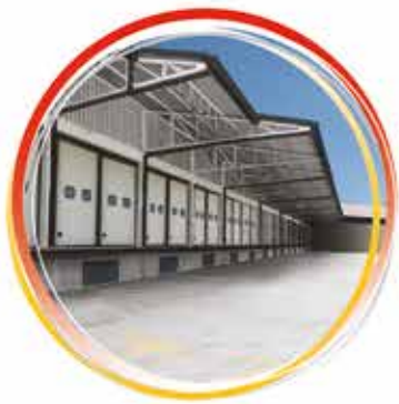
Manutenzioni civili e industriali
