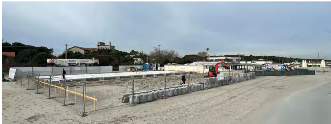
Il cantiere del bagno Insieme a Te di Punta Marina Terme a cui sta lavorando Cmcf
