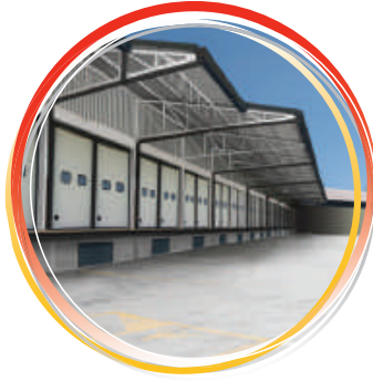
Manutenzioni civili e industriali
