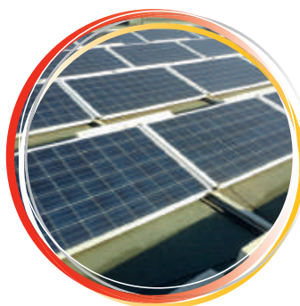
Interventi di risparmio energetico
