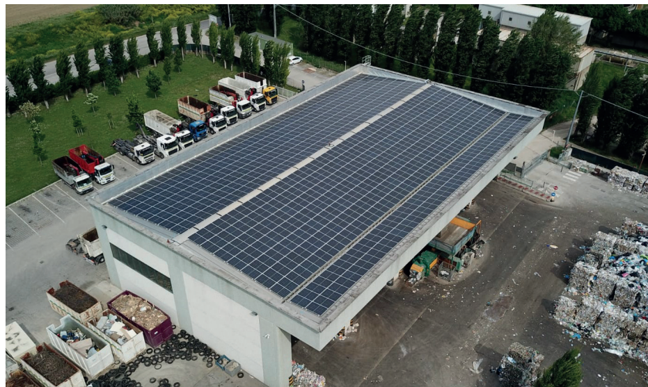
Lo stabilimento della cooperativa Il Solco dove si trovano uffici e impianti
