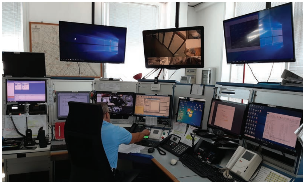
Una parte della centrale operativa di Colas Vigilanza che si trova nella sede di Ravenna
