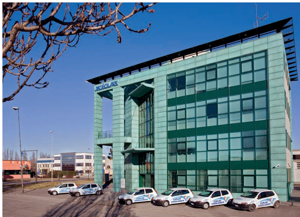
Il centro direzionale del Gruppo Ciclat in via Romagnoli a Ravenna
